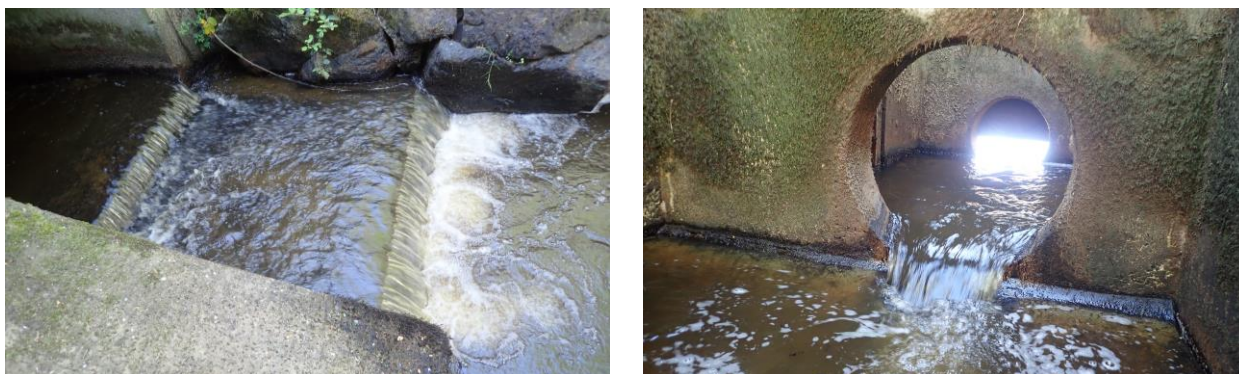
Figure 24 : A gauche, chute résiduelle en aval du passage busé et à droite petite chute résiduelle en aval de la seconde ouverture circulaire au niveau du vannage (Fish-Pass)
