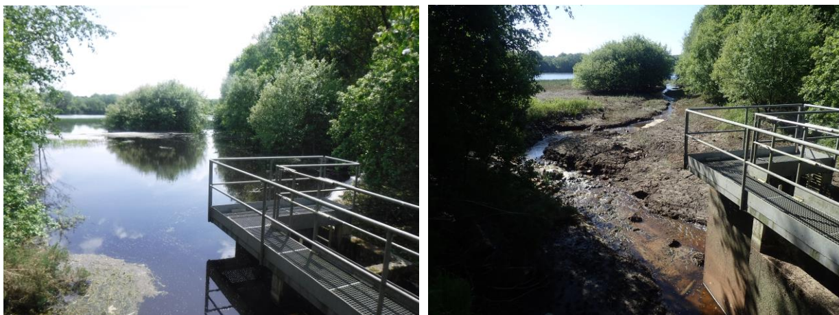
Figure 22 : Illustrations de l'évolution des niveaux d'eau entre début et fin mai 2020 suite à l'ouverture du vannage (Fish-Pass)
